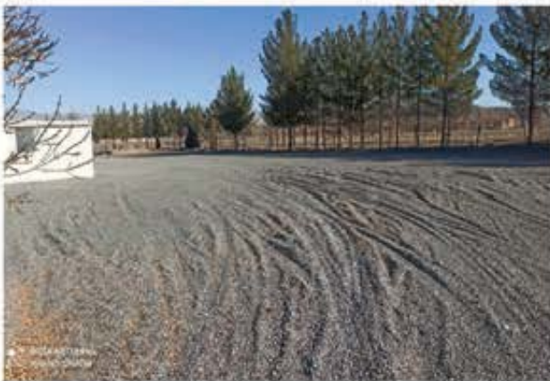
◀ آمادسازی فضای بیرون پردیس علوم رفتاری
