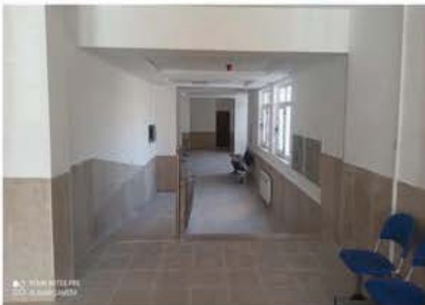
◀ ایجاد سطح شیب دار جهت ورود و خروج افراد دارای معلولیت
