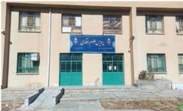
◀ ایجاد سطح شیب دار جهت ورود و خروج افراد دارای معلولیت
