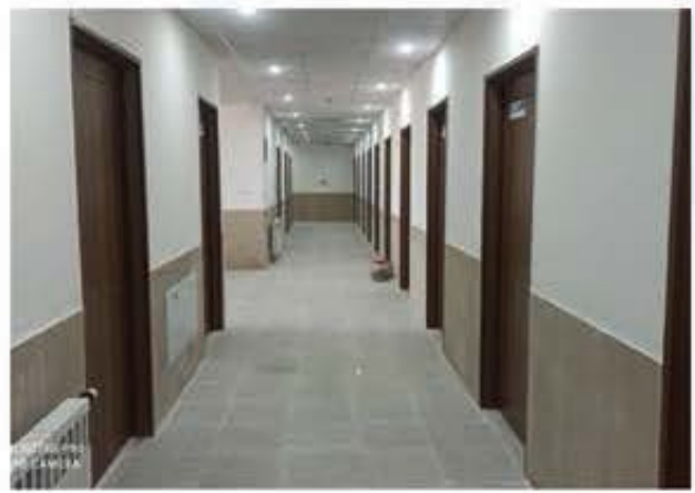
◀ نمای داخلی دو طبقه پائین و بالای ساختمان جدید پردیس علوم رفتاری
